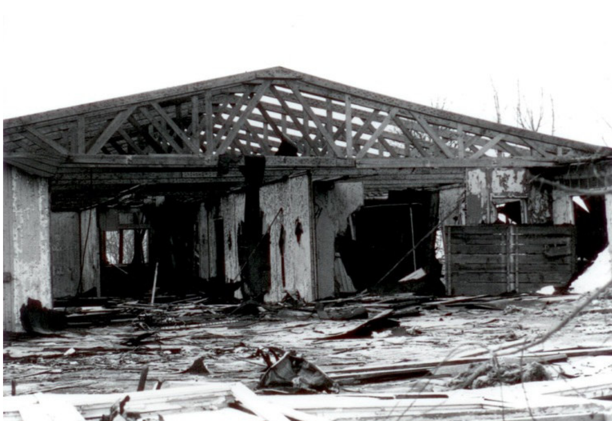
Rozebírání Kulturního domu dne 4. 3. 2005.
