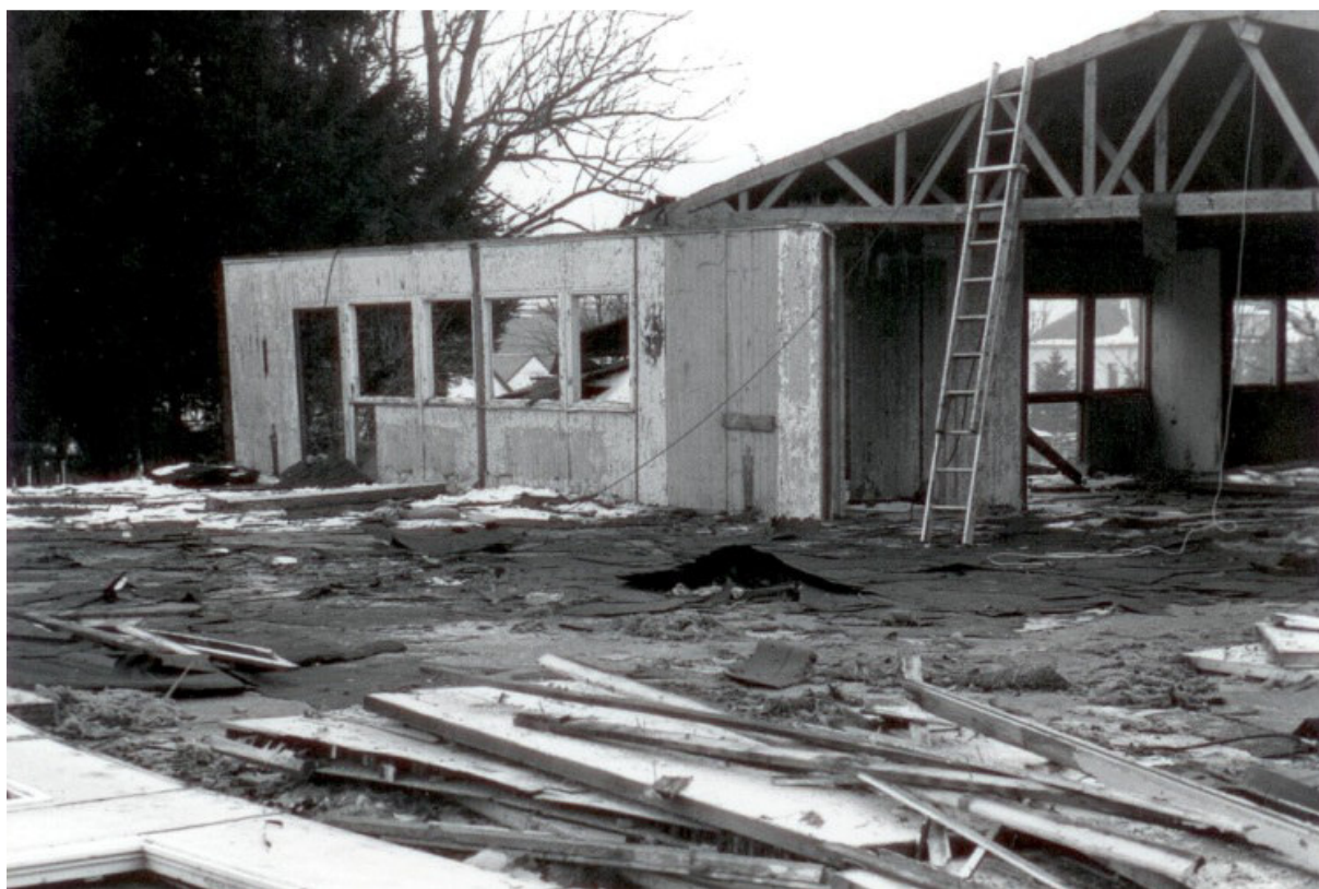
Rozebírání Kulturního domu dne 3. 3. 2005.
