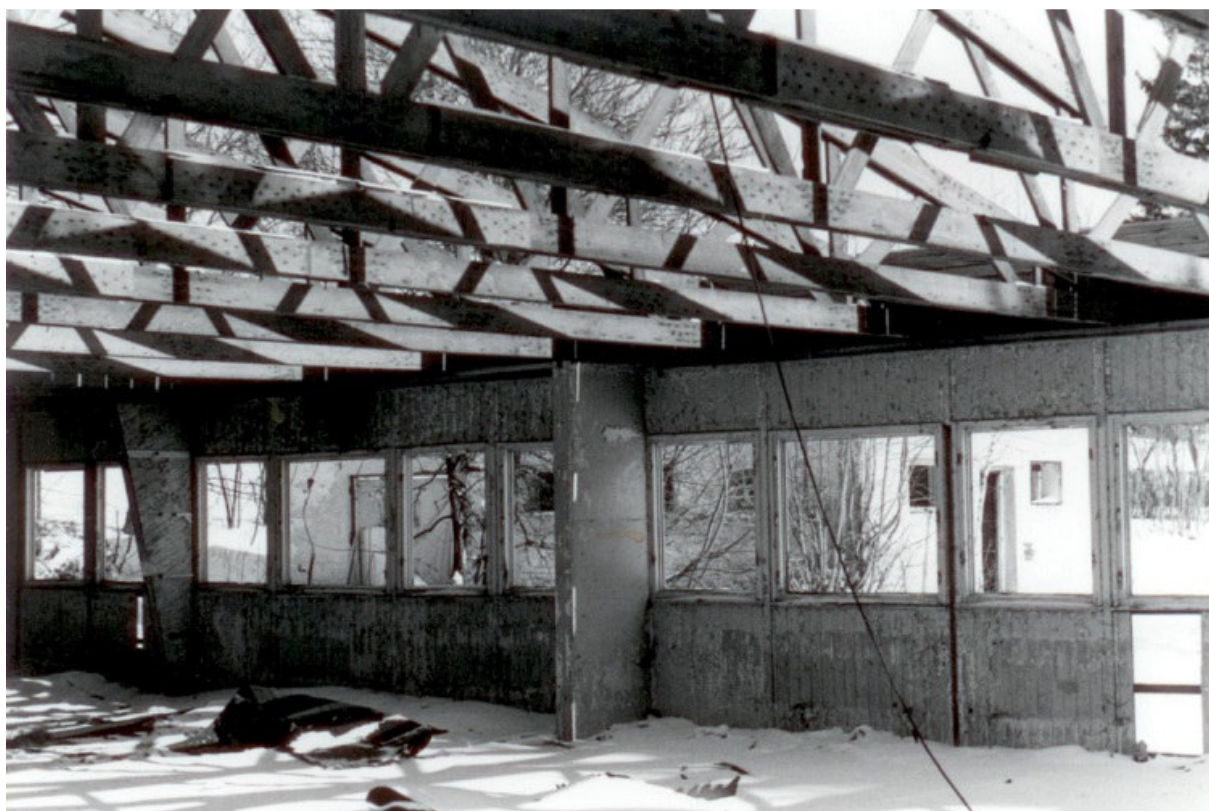
Rozebírání Kulturňho domu dne 27. 2. 2005.
