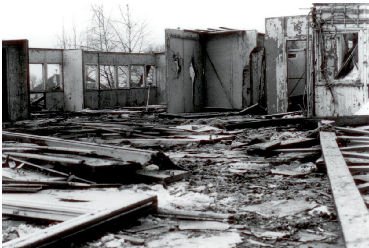
Rozebírání Kulturního domu dne 11. 3. 2005.
