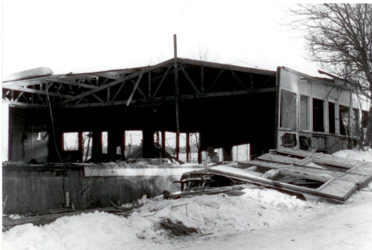
Rozebírání Kulturňho domu dne 2. 3. 2005.
